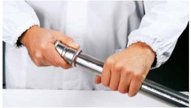
Рис. 31. Вставка трубы в пресс-фитинг.
