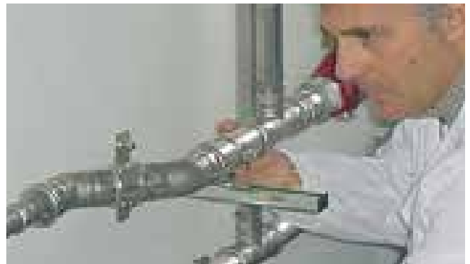
Рис. 33. Проверка пресс-соединения.
