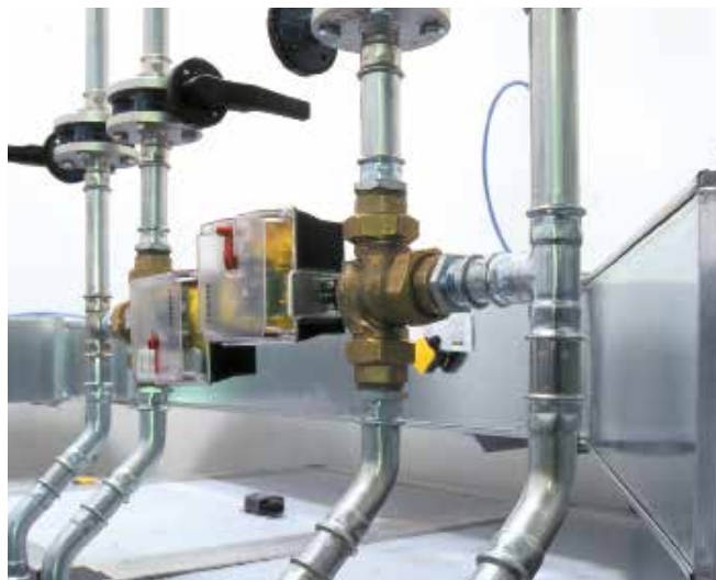
Рис. 22. steelPRES — контур охлаждения.
