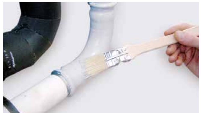
Рис. 34. Покраска соединений и труб праймером.
