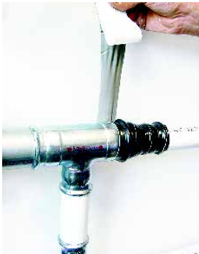
Рис. 35. Защита соединений с помощью бутаноловой клейкой ленты.
