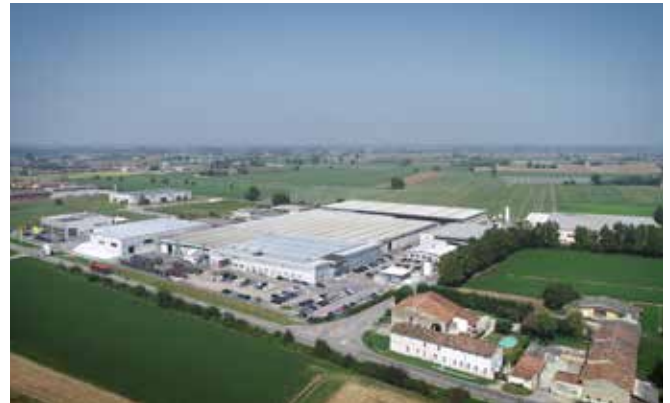
Рис. 1. Главный офис и фабрика в Кампителло.
