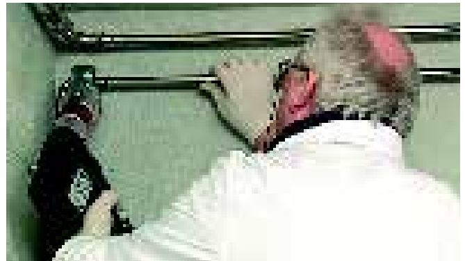
Рис. 32. Опрессовка.
